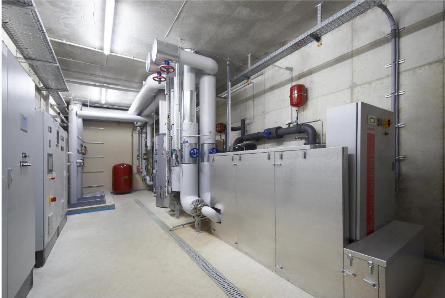
Abbildung 5: Blick in den Heizraum. Im Vordergrund WP OCHSNER ISWS150ER2 samt kompletter Schallschutzverkleidung
